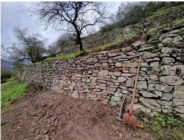
Trockenmauersanierung, Foto: A. Michaeli
