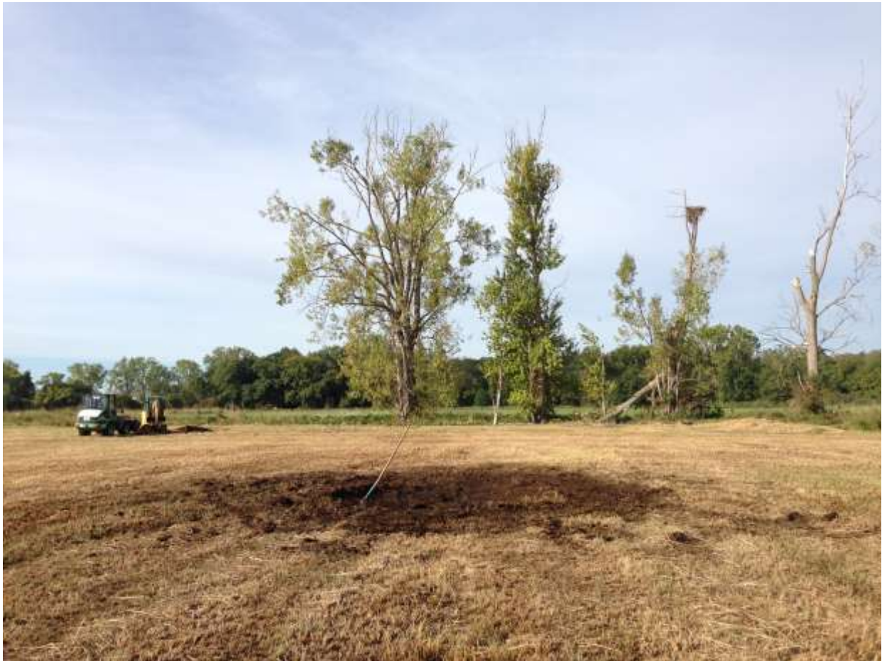
Baggerarbeiten im Gebiet „Bruchwiesen Büttelborn“/Modellierung der Mulden
